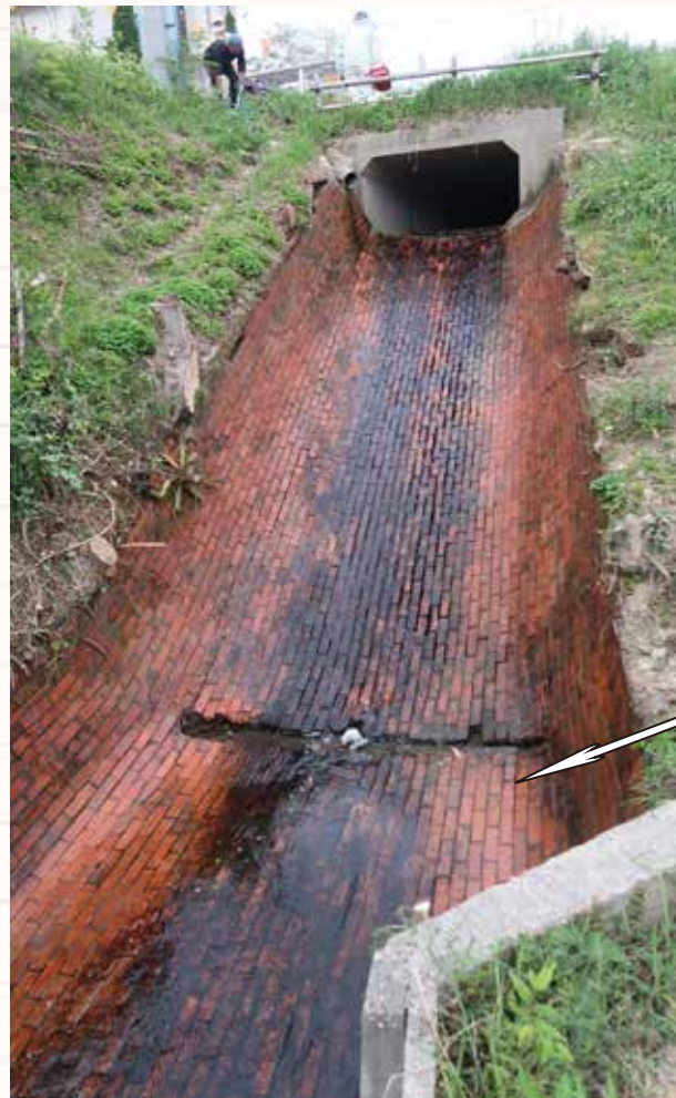
▲清掃後のレンガ用水路(横根町平子・宝池近く)幅2.7m、長さ 斜面7.7m、平面1.9m
